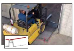
Обычные доклевеллеры имеют зазор в области задних петель, что приводит к возникновению различных вибраций и ударов при проезде погрузчика,
